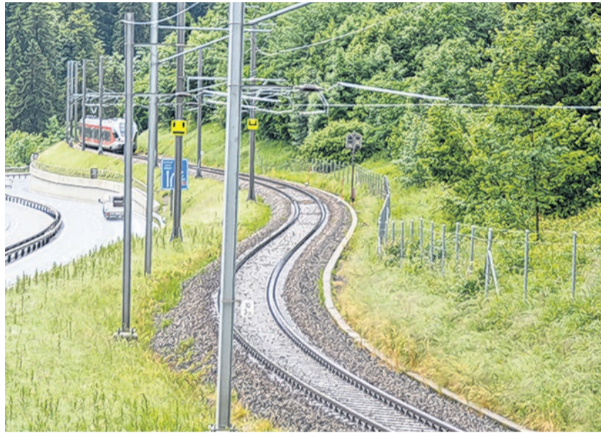
Die SOB-Züge zwischen Schindellegi und Biberbrugg können unterwegs nicht kreuzen. Das Doppelspur-Projekt ist planerisch zwar weit fortgeschritten, der Zeitplan für die Umsetzung ist jedoch noch nicht klar.
